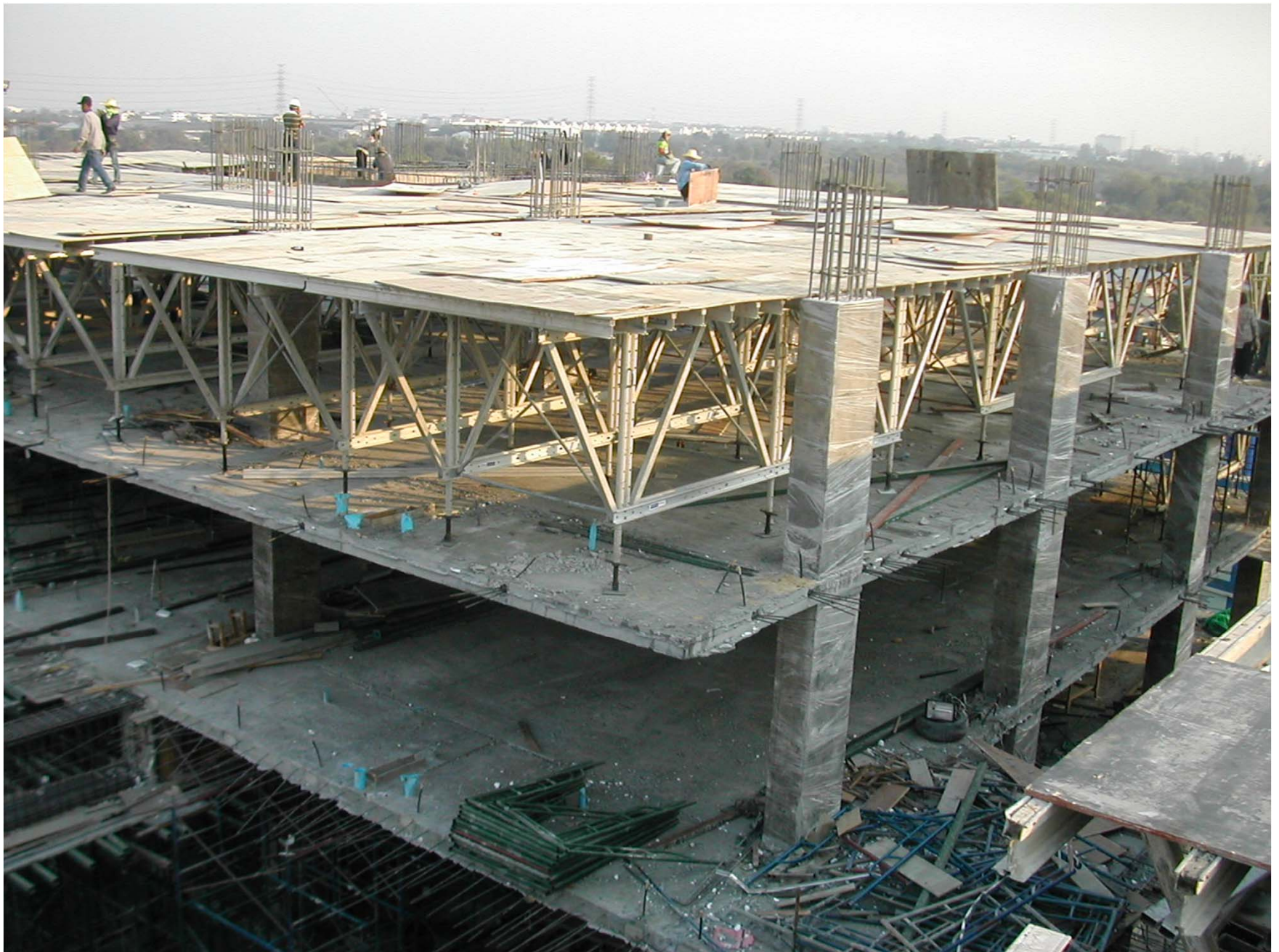
ระหว่างก่อสร้าง
