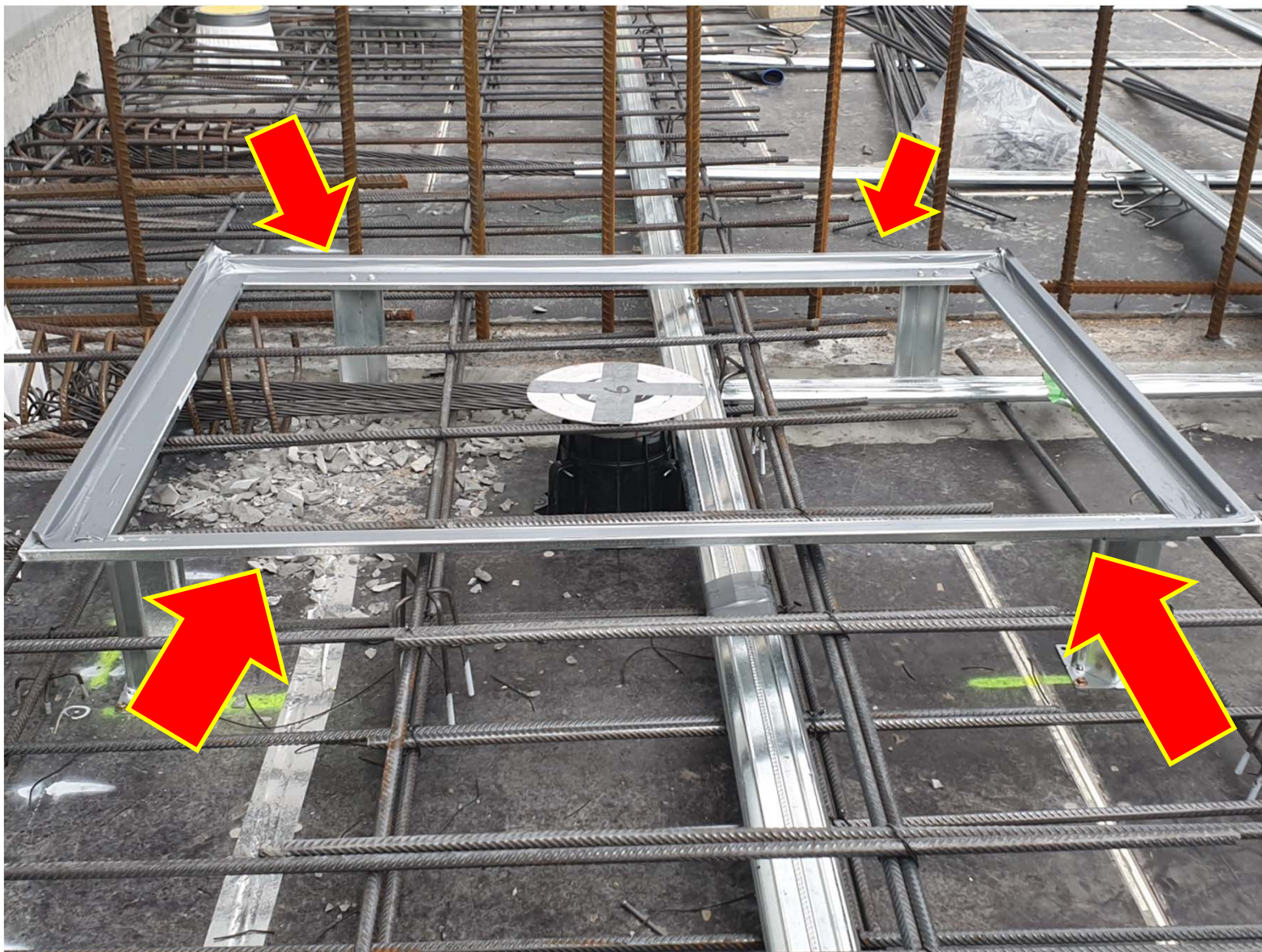
การเปลี่ยนระดับ ห้องน้ำ
