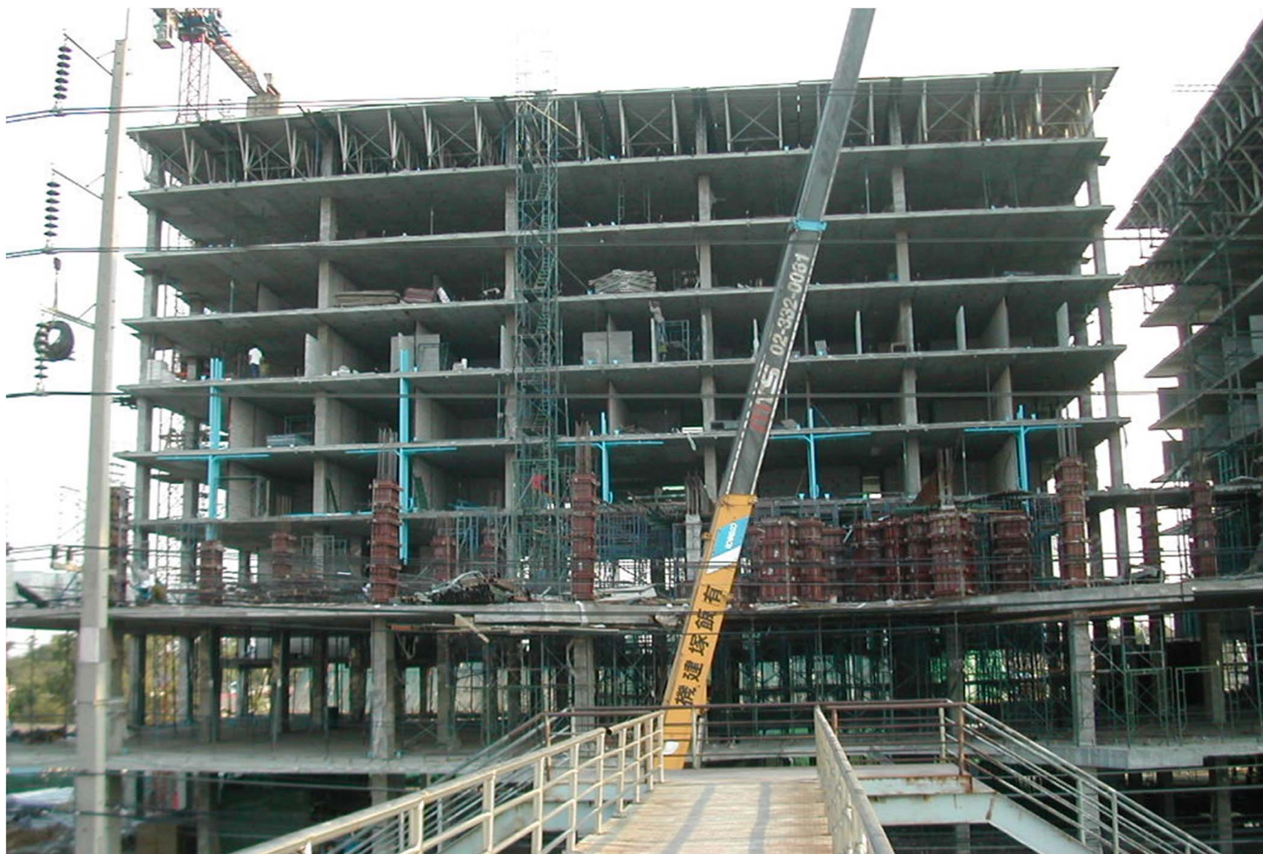
ระหว่างก่อสร้าง
